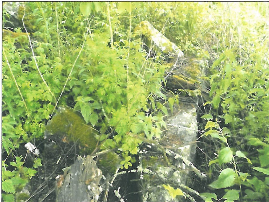
Vanhan myllyn rakenteita.
