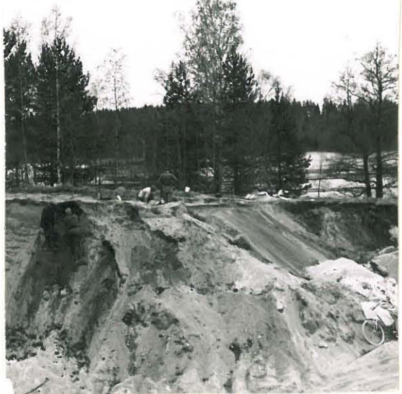
Kaivausalue kuvattuna länneestä
