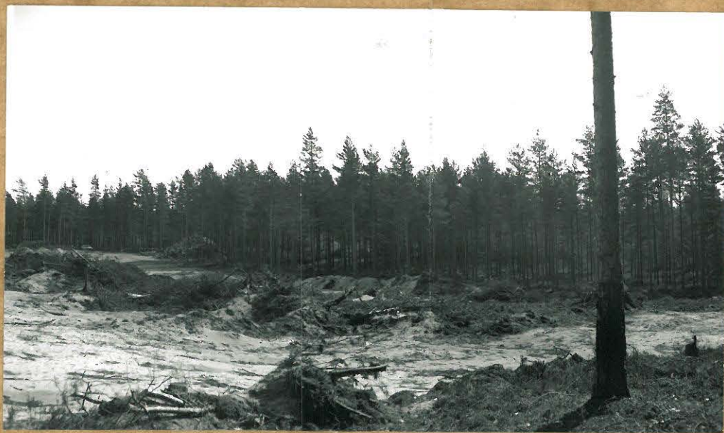
F. 90056-57 Panoraamakuva kaivausalueelle, kuvattu kalkkialueen reunalta, lännestä, vasemmalla murskealue
