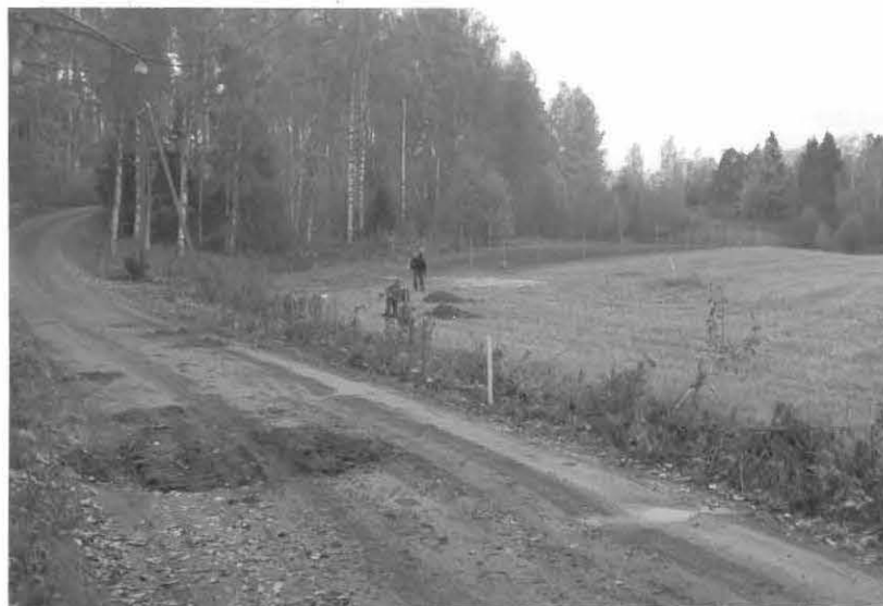
neg. 128 319. Toivolan yllitärällä kaasulinjalla kaivetaan koekuoppia. Kaakosta.
