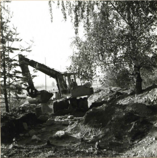
F 71093 Kaivausalueen koneellinen täyttäminen käynnissä NW-SE
