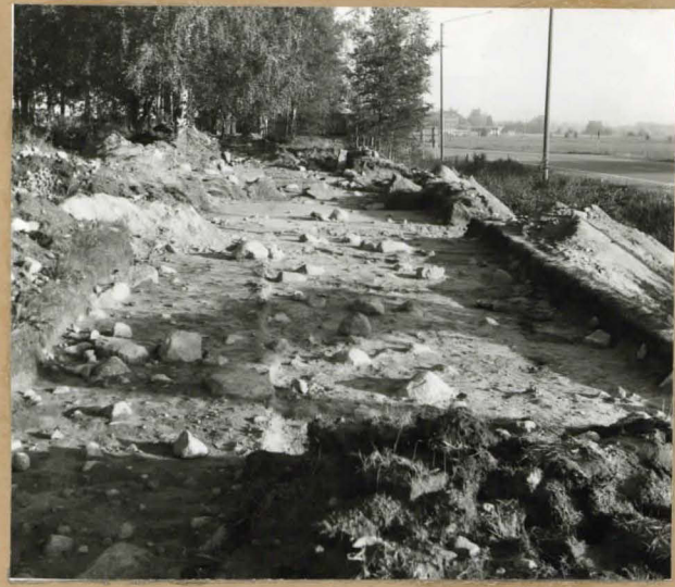
F 71090 Kaivausalue ennen täyttämistä SE-NW
