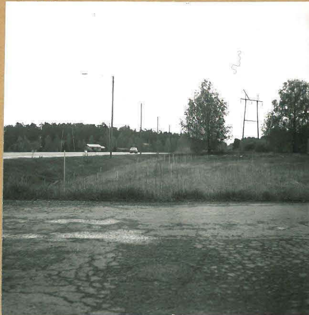
Kuva 2. Pohjoimen kaivausalue paalutettuna, luoteesta.
