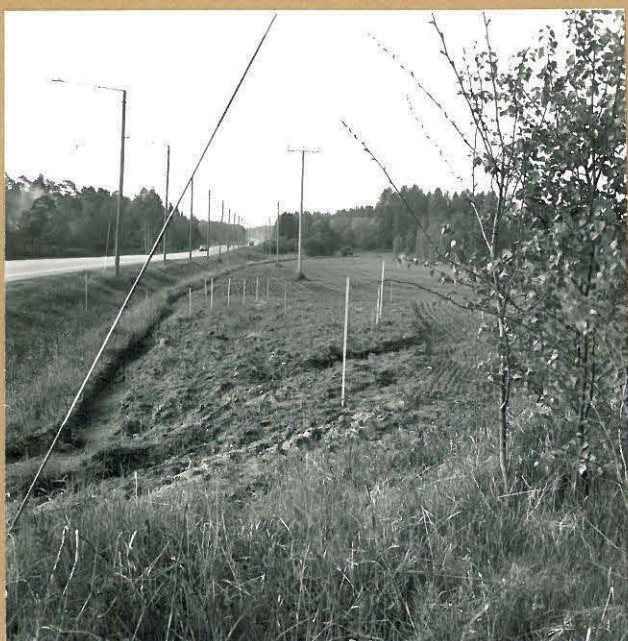
Kuva 4. Yleiskuva etel. kaivaus- alueesta paalutettuna, pohjoisesta.
