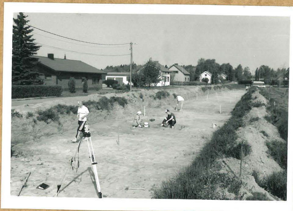
KUVA 2 (89222). Työkuva. Tutkimusalue paalutettuna, aluetta puhdistetaan. Kuvattu kaakosta.
