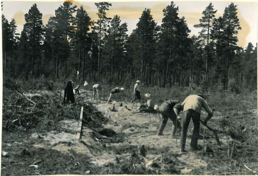
18. Kaivausten alkuvaihetta. f. 32735
