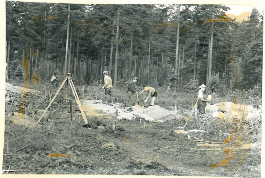
19. Kaivausten loppuvaihetta. f. 32729
