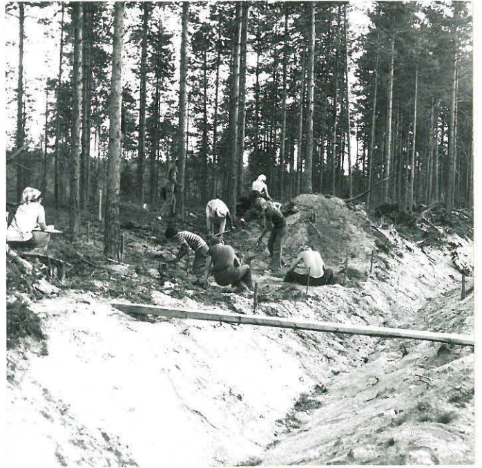
KAIVAUS ALKUPHASSA SYVENNYS I:O KOHDALLA LEIKKÄTUKSESSA
