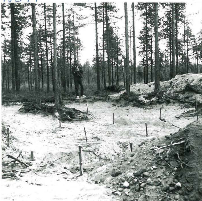
13 SYVENNYS I KAIVETTUNA, TÄSÖ?
