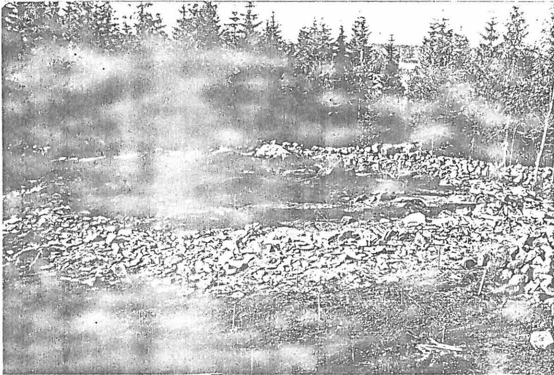
Röykkiö purettuna, kuvattu tornista, NE-suunnasta. (TYA neg. F 11680) Reunakehä jätetty purkamatta.
