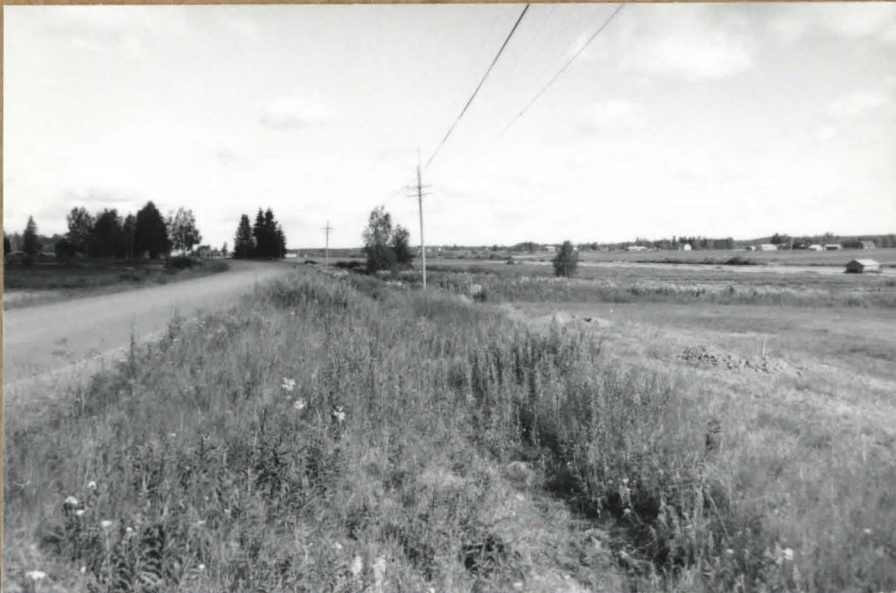
79745. KAIVUSALUETTA KOKOUKITETTUNA. KOOJAN 355-394/200 ETELÄPÄÄN PINTAMULTAA KAIVETAAN POIS. KAAKOSTA.
