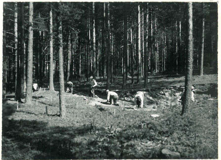
Kaivausalue etelä- kaakosta.
