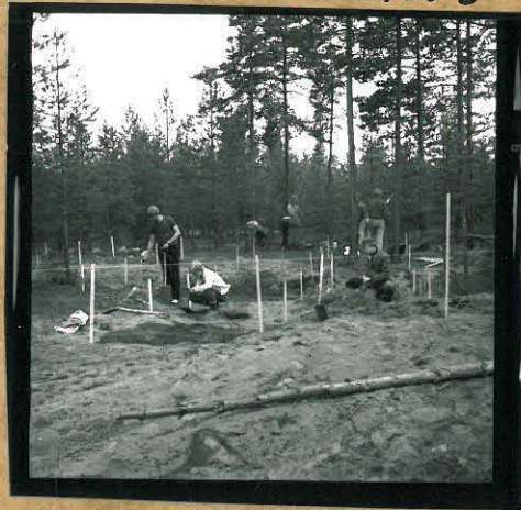
Kaivauksia aloitellun. Ves. siirto pöytä ja Tuor- Väntäsen
