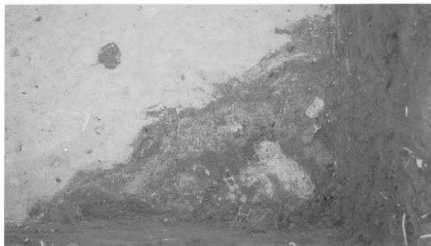
Neg.nro 132162 Sama, yksityiskohtakuva rakenteesta. Lännestä. Kuva K. Vuoristo.
