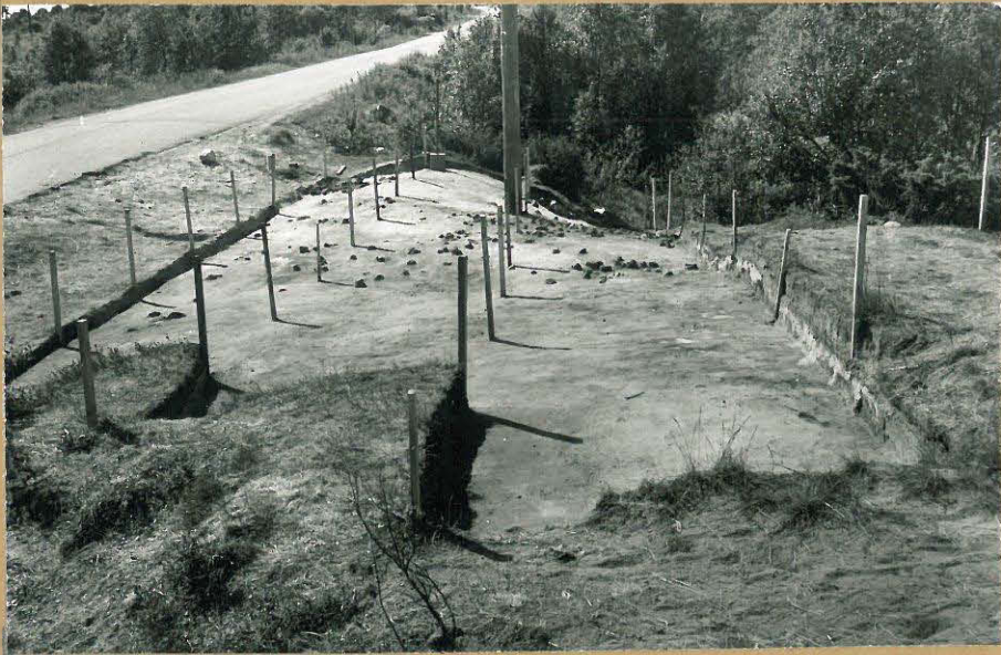
69369. Taso 4, yleiskuva koillisesta.
