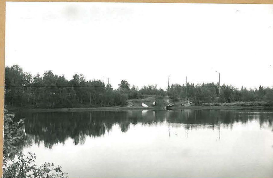
69335. Yleiskuva luoteesta, kaivaus veneiden takana.
