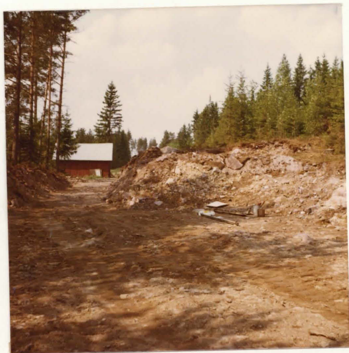
Kaivausalve II. Kuvattu kaakosta.
