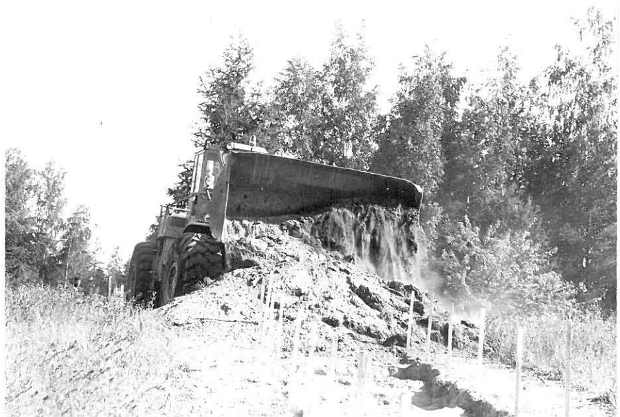
5 KUVA 5 HETI KAIVAUKSEN JÄLKEEN ALKOI PAI- → KALLA HELSINKI- LANTI MOOTTORITIE TEN
