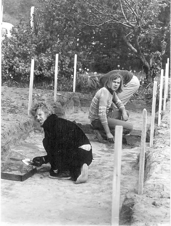
← KUVA 2. LINJAN A KAIVAUS KUVA KAAKOSTA f. 36417
