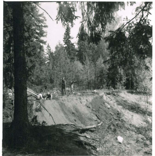
6. Työkura alueelle pohjoisesta päin.
