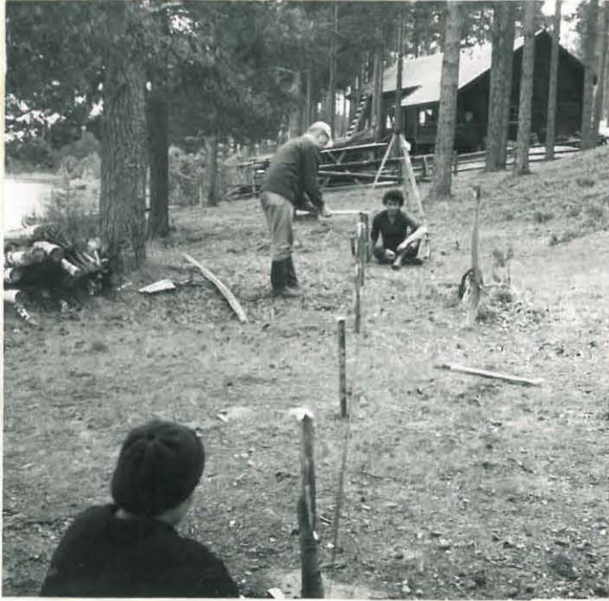
KUVA 1. ALUETTA PAALUTETAAN TAUSTALLA YHTYNEITTEN PAPERITEHTAITTEN RAKENNUKSIA
