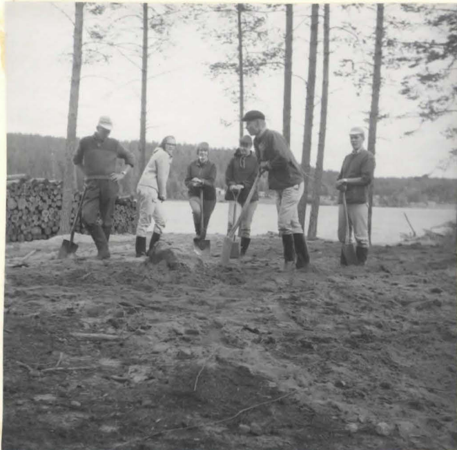
KUVA 45. TYÖ TEHTY ON..
