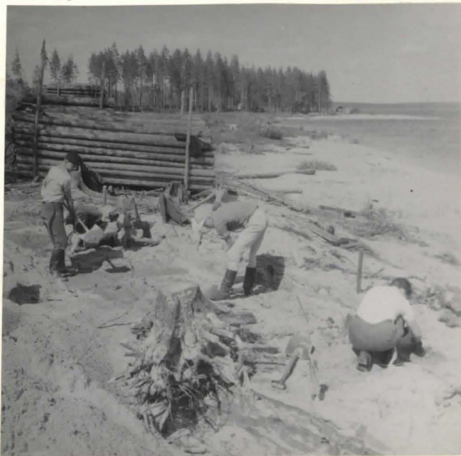
KUVA 8 KAIVAUSTA RIVILLÄ II
