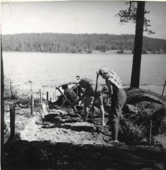
KUVA 2. KAIVAUSTA VONKKA I:ssä
