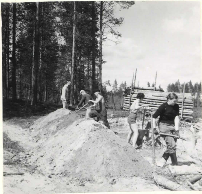
KUVA 6. KAIVAUSTA RIVILLÄ I
