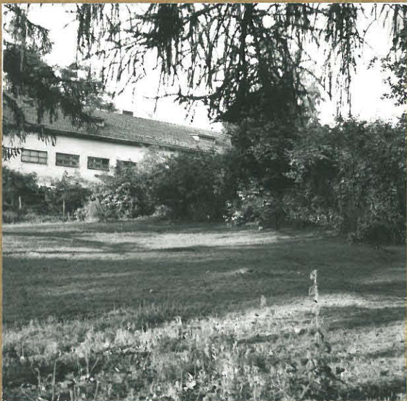
F83187 Kuva 3. Yleiskuva tallin takaa. Kuva koillisesta.
