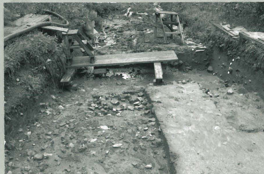
neg. 94100 K. 11. Kaivausalueen itäpää tyhjennöksen jälkeen, lännestä.
