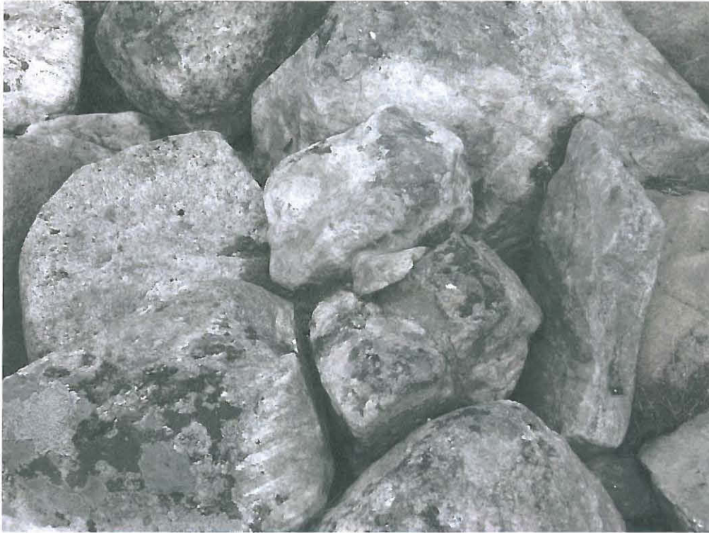
Kuva 3. Röykkiön pinnan rakennekiveystä. Isompien kivien väliin asetettuja tilkekiviä.
