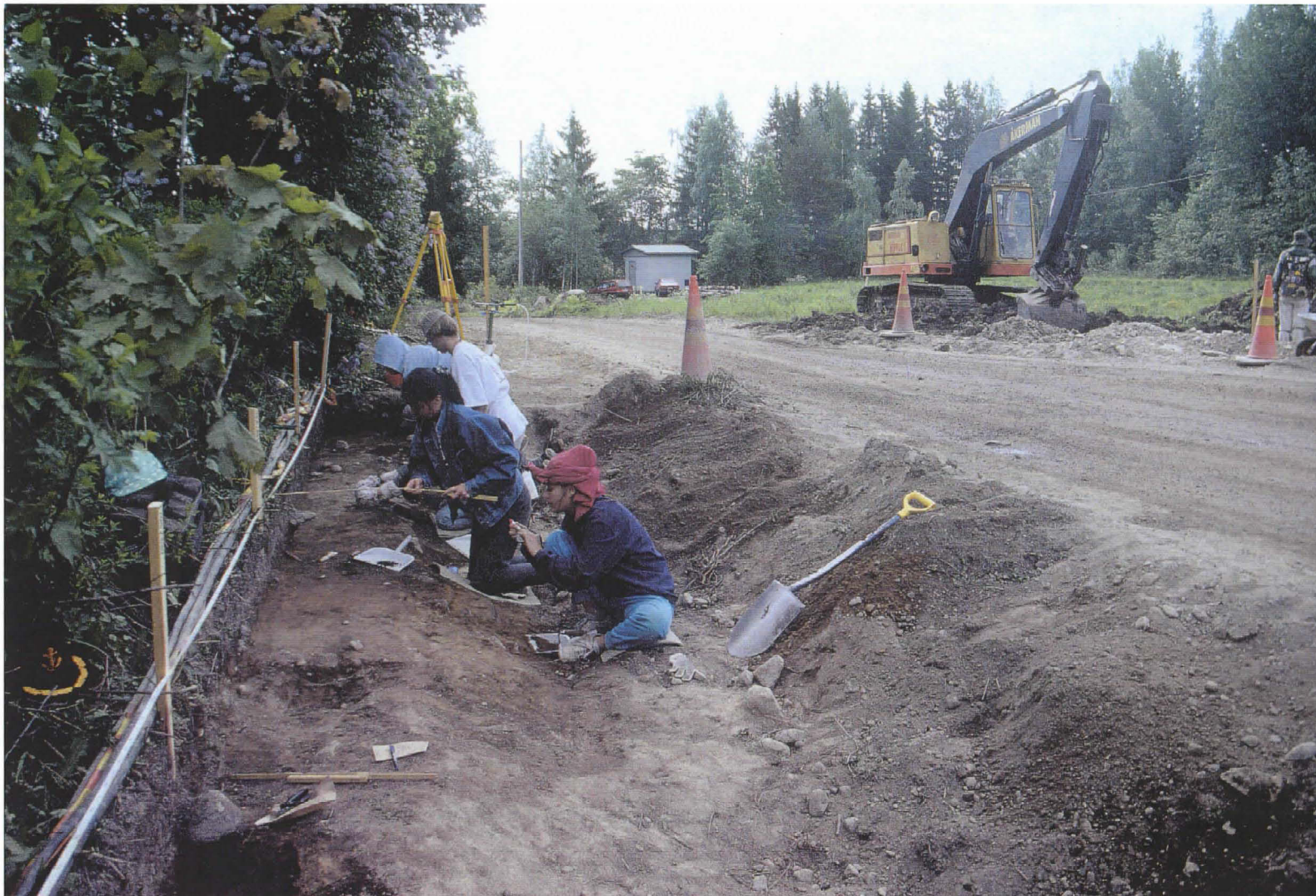
32902 Yleiskuva. Kaivausalueetta 100-110/500-501 puhdistetaan tasoon 1. Taustalla kuoritaan uuden tien kohtaa. Länsiluoteesta. Kuva S.-L. Seppälä.
