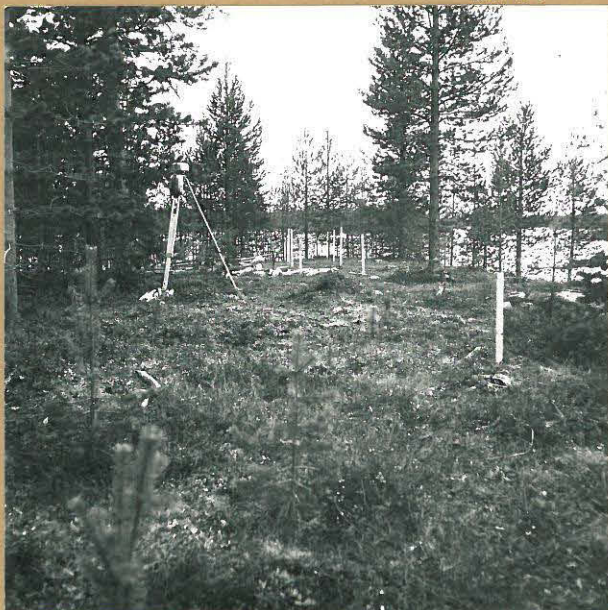
K.3 KAIVAUSALUE PAALUTET- TUNA IDÄSTÄ
