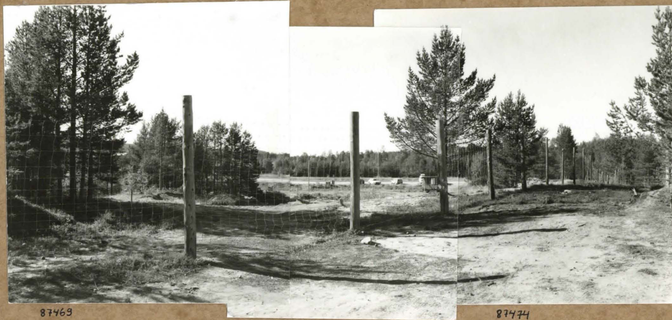
Alue 332-334/380-398 peitettyä. Koillisesta.
