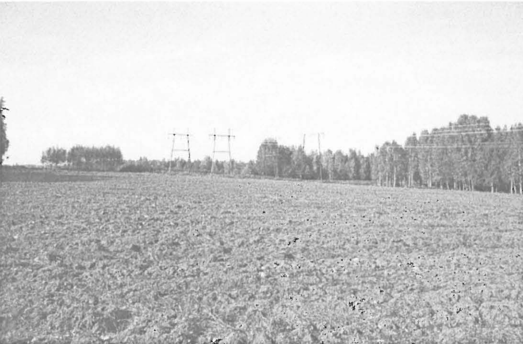
Pylväs 124. Katselusuunta kaakosta.
