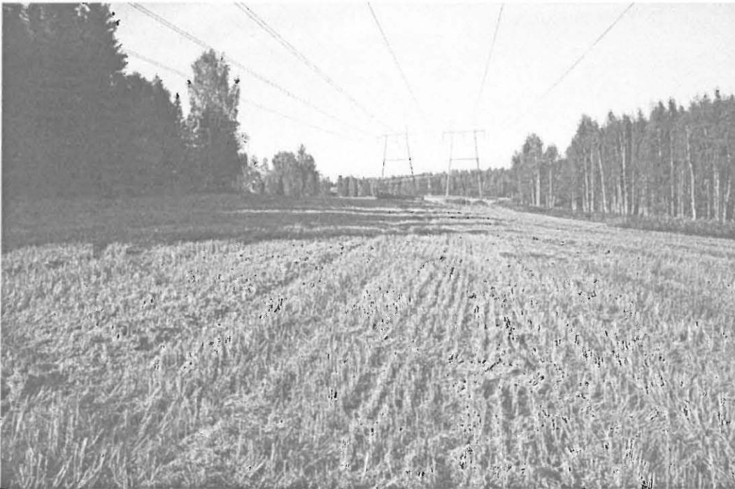
Pylväs 122 sekä peltoaluetta. Kuvattu etelästä.
