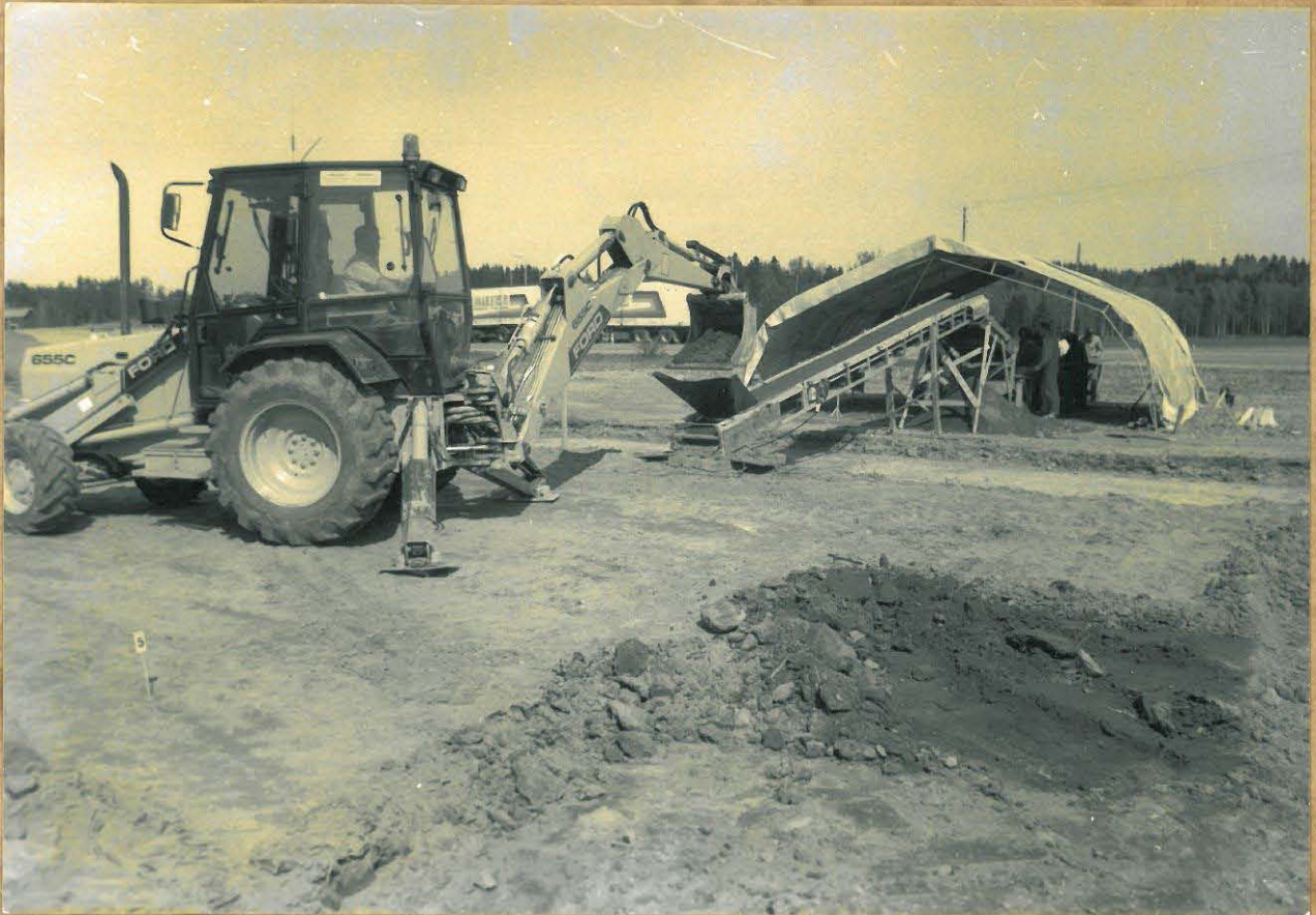
Kuva 27. Työkuva. Kaivinkone poistaa peltokerrosta. Säisuojaan alla seularyhmä.
