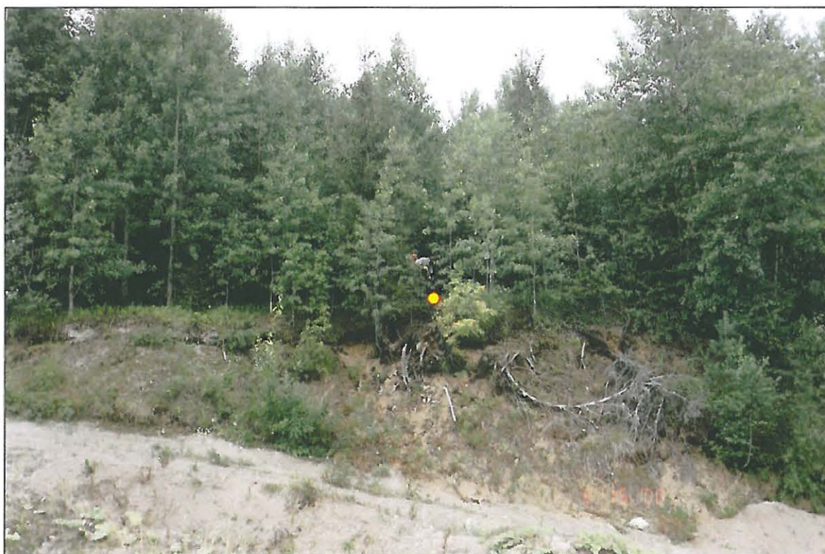
Kuten yläkuva. Kaivausaluetta avataan.
