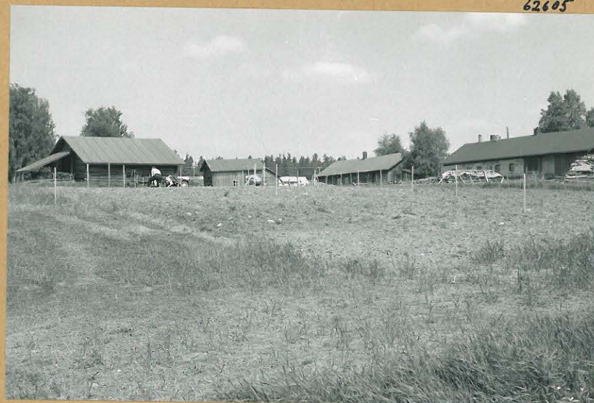
K.2 Yleiskuva kanavalueelle, kohti pohjoista
