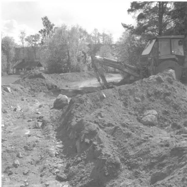
KUVA 13 F.132786 Reijo Inna kaivaa uutta peltotietä, kuvattu pohjoisluoteesta.
