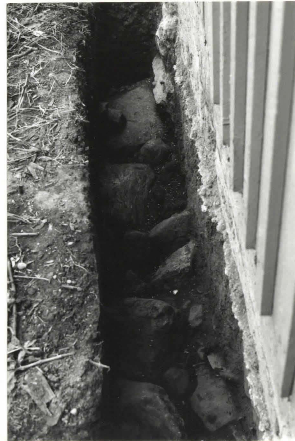
F. 116991 Seinän vieressä kaapeliöjä kaivettu kalustekoroksen pintaan, n. 15cm:n syvyyteen kuvattu koillisesta
