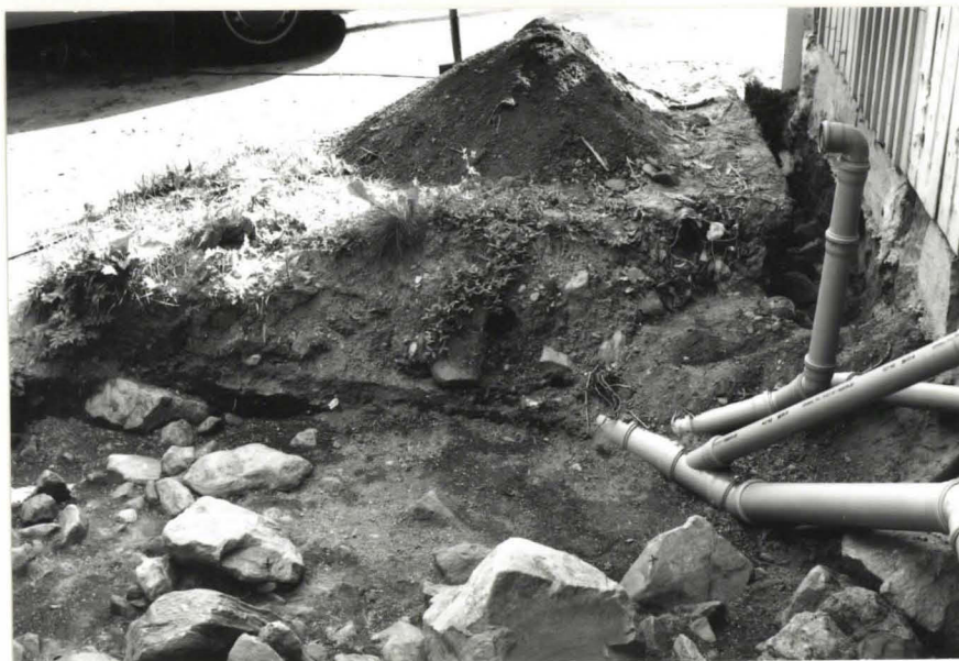
F. 116993 Kaivausalueen länsikulma ja kaapelioja, kuvattu koillisesta
