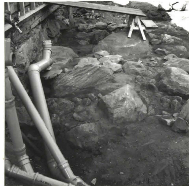
F. 116990 Kaivausalueen talon polcinen reuna, tilapäisen rapparakenteen alta löytyi tasuaurallinen solki, kuvattu lounaasta
