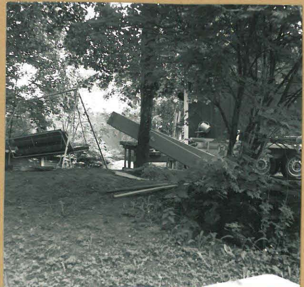
F. 95201 Savnalta kuvattu varastorakennuksen pohjoispiätyä, vanhaa 1930-luvun kaivausaluetta, täytömaata, kuvattu luteesta
