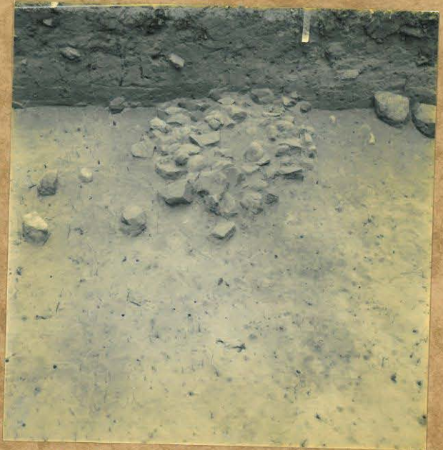
F. 91129 Tulisija 1 ruuduissa 681-682/340 taso 2 kuvattu pohjoisesta
