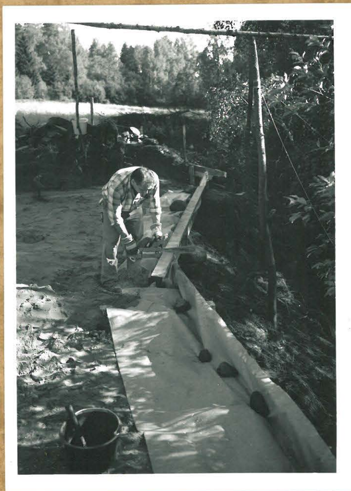
97214. Kalmusto kivetyksen sutiöintiä valmistellaan tuke malla hiellä kuopan reunalle tulevaa osaa päärakentein ja suodatin kankain. Työssä ovat Markka Ristinen ja Kari Uhlgren, S-N M. Moisanen - 93
