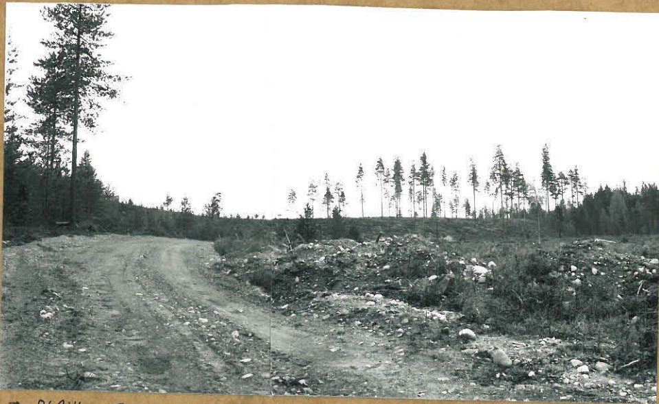
F. 86246-47 YLEISKUVA HARJULLE. KUVATTU SORAKUOPALLE JOHTAVALLA TIELTÄ, KAAKOSTA
