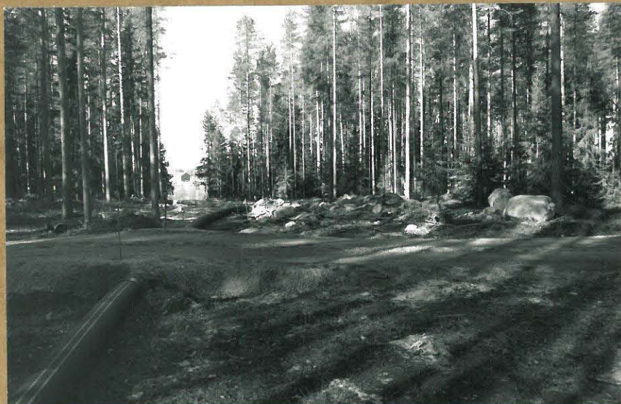
YLEISKUVA PUTKILINJALTA JOELLE PÄIN. KESKELLÄ KAIVINKONEEN TUHOAMA HAUTA-ALUE
