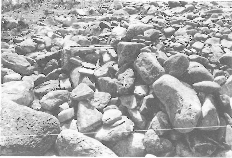
Kuva 3. Rökkiön 8 pohjoisreunan lierirakennetta.
