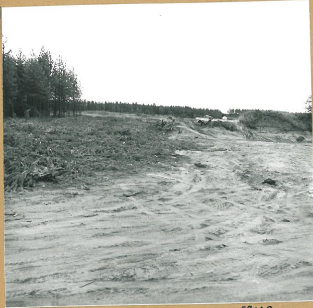
1. Yleiskuva kaivausalueesta 59029 ennen pealutusta. W.
