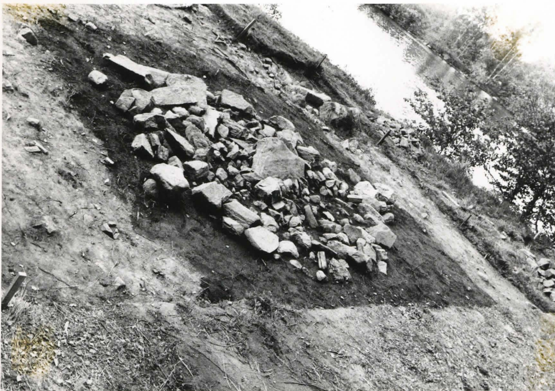
TYA 5461 RAUNIO TASO 3:1 KUVAUTTU YLÄPOHJOISESTA TUMMA ALUE KASTETTU.
