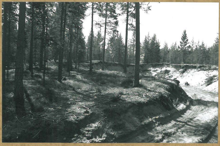
F.111000 SORAKUOPPA, JOSTA IRTOLOHTOJA. SINÄITSEE N. 200M. KAIVUUSALUELTA ETELÄÄN.
