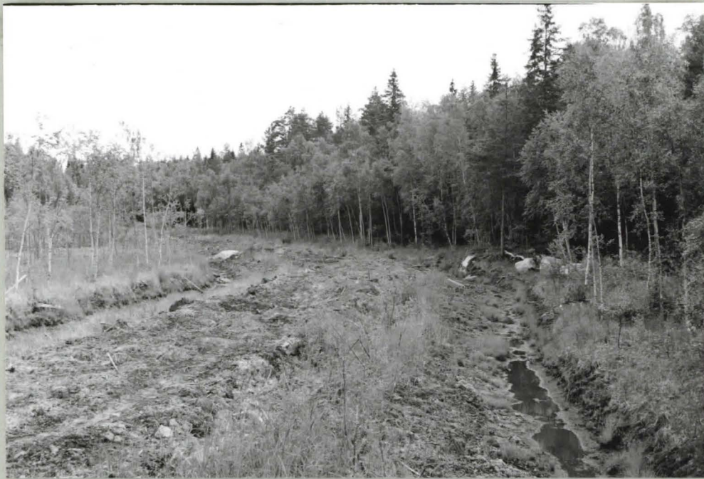
F 92349 Grävningssplatsen i Verkträsket mitt i bilden sedd från sydväst.
