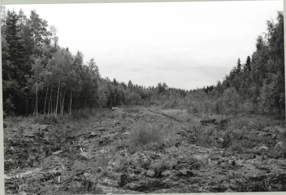
F 92348 Verkträsket från norr med grävningssplatsen mitt i bilden
