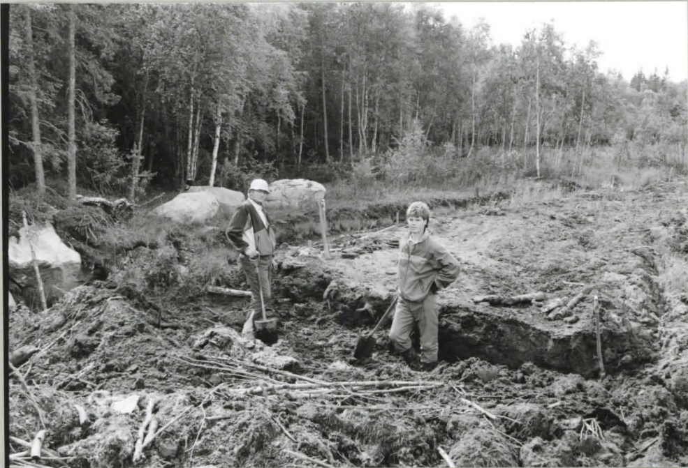
F 92350 Arbetsbild. Fyllnadstorven i vägbanken avlägsnas. Fr. v. Markus Riska och Sven Vikström.
