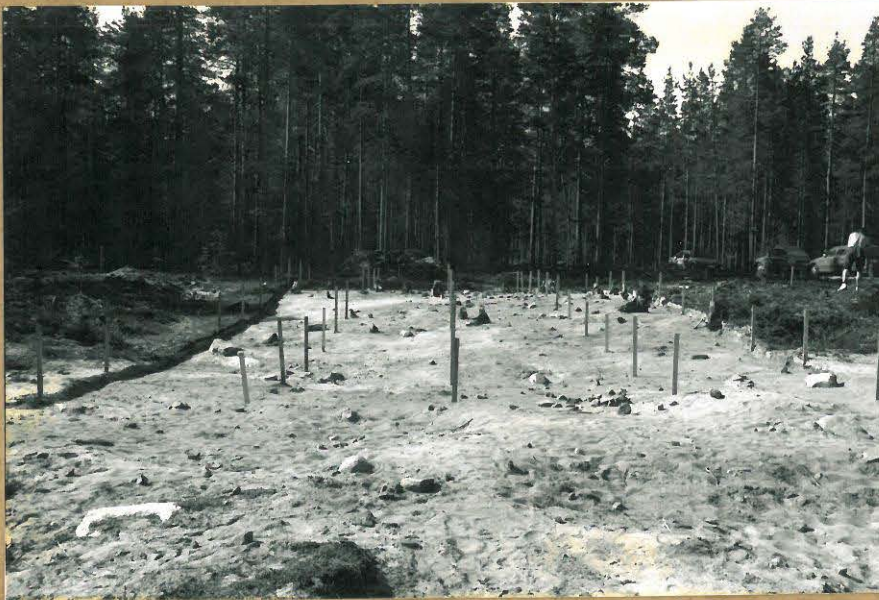
F. 108486. Alue 9, taso 1. Kuv. pohjoisesta.
