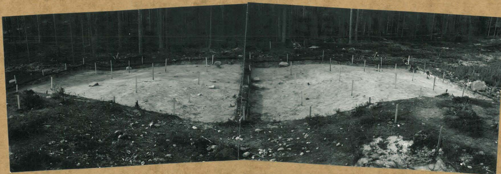
F. 108521 - 22. Alue 8, taso 4. Kuv. pohjoisesta.
