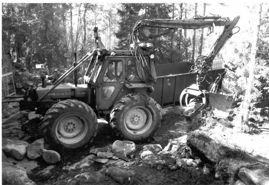
Kuva 32. (f. 134644) Työkuva. Kone siirtää suuria kiviä pois kaivausalueelta.
