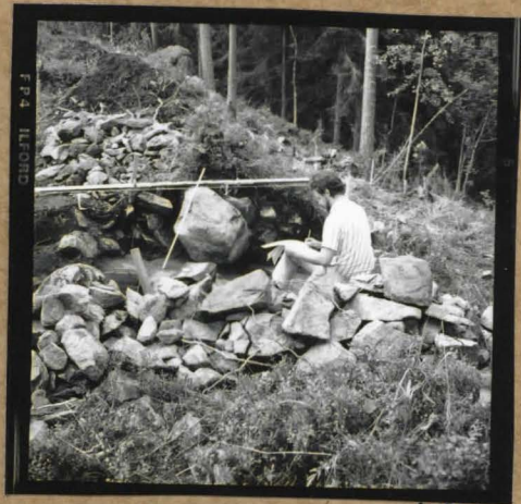
Seppo Rintala puitamossa muurin perustustöitä
