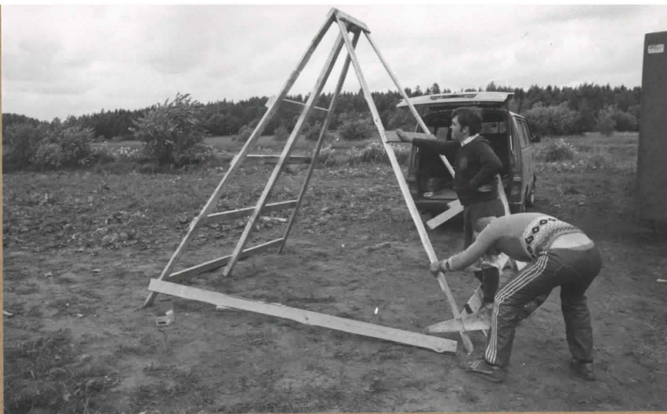
KUVA 13. Valokuvauustornia rakennetaan. neg. LKHM 58312. kur. Hannu Poutiainen
