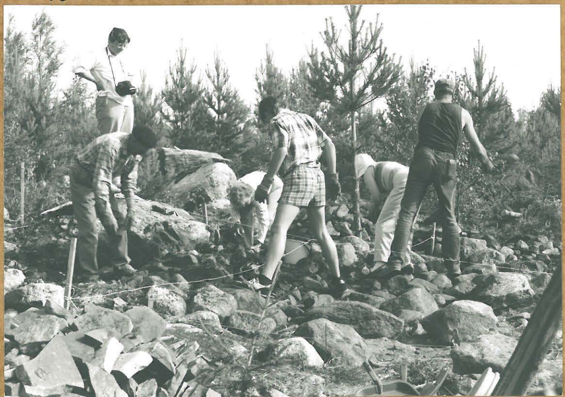
NW puolelta purkamista
