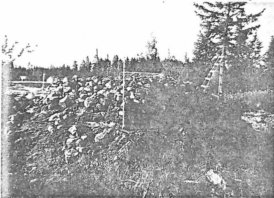
2. Röykkiö pohjoisesta ympäristön perkauksen jälkeen.
