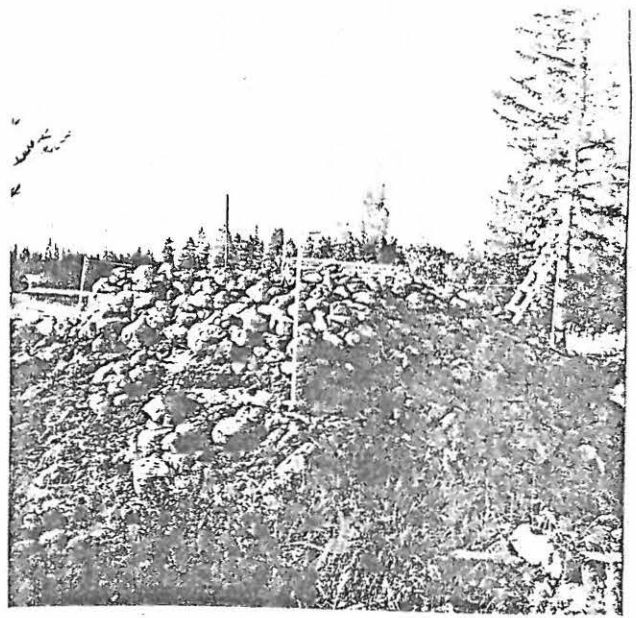
9. Pohjoisesta perkauksen jälkeen.
