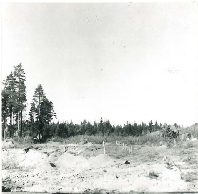
Kuva 5. Paalutettua tutkimus- aluetta etelästä kuvattuna.
