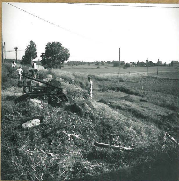
f. 78034 Kuva 3. Koekäiväusalue heinikon poiston jälkeen, kuvattu etelästä navetan seinustalta.
